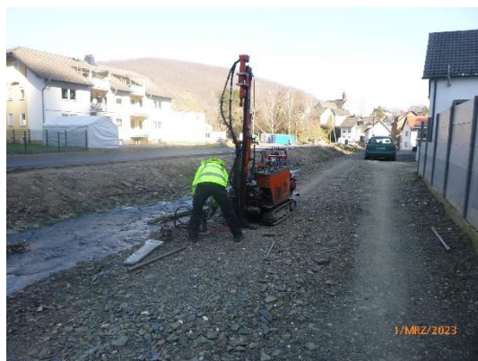
Foto 2 01.03.23: BS 5, Blick Nordost
